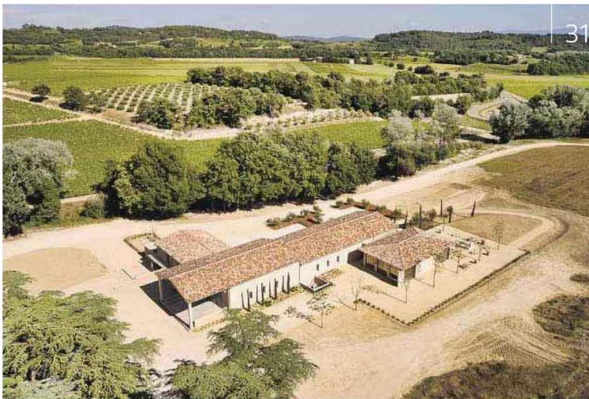
Conçu dans le style de la bastide provençale de la propriété, le nouveau bâtiment semble avoir toujours existé. SERGE PAPIN
